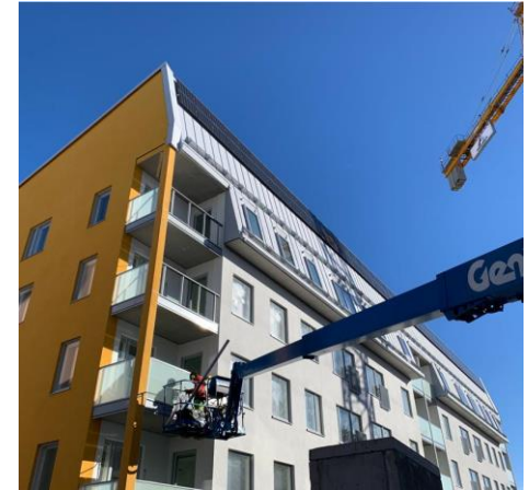
Kuva eQ Asunnot -rahaston työmaalta Helsingin Kannelmäestä 4.3.2022. Asunto Oy Helsingin Vanhaistentie 1 C.
