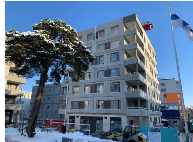
Kuva eQ Asunnot -rahaston työmaalta Helsingin Laajasalosta 5.2.2021. Asunto Oy Helsingin Kaiku 4 / Yliskylän Puistokatu 7, 43 asuntoa. Kohde valmistuu joulukuussa 2021.
